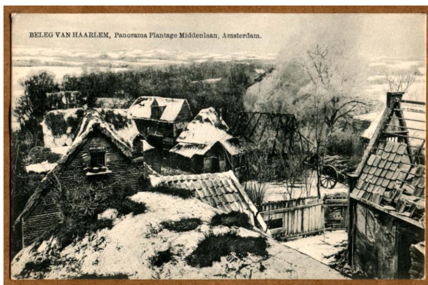
70. Ansichtkaart van een detail uit 'Het beleg van Haarlem' na de restauratie.
